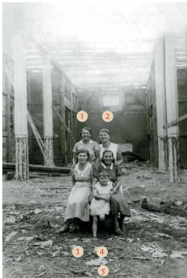
WNĘTRZE STAREGO KOŚCIOŁA ŚW. JAKUBA W IMIELNICY W TRAKCIE ROZBIÓRKI, 2 LIPCA 1935
