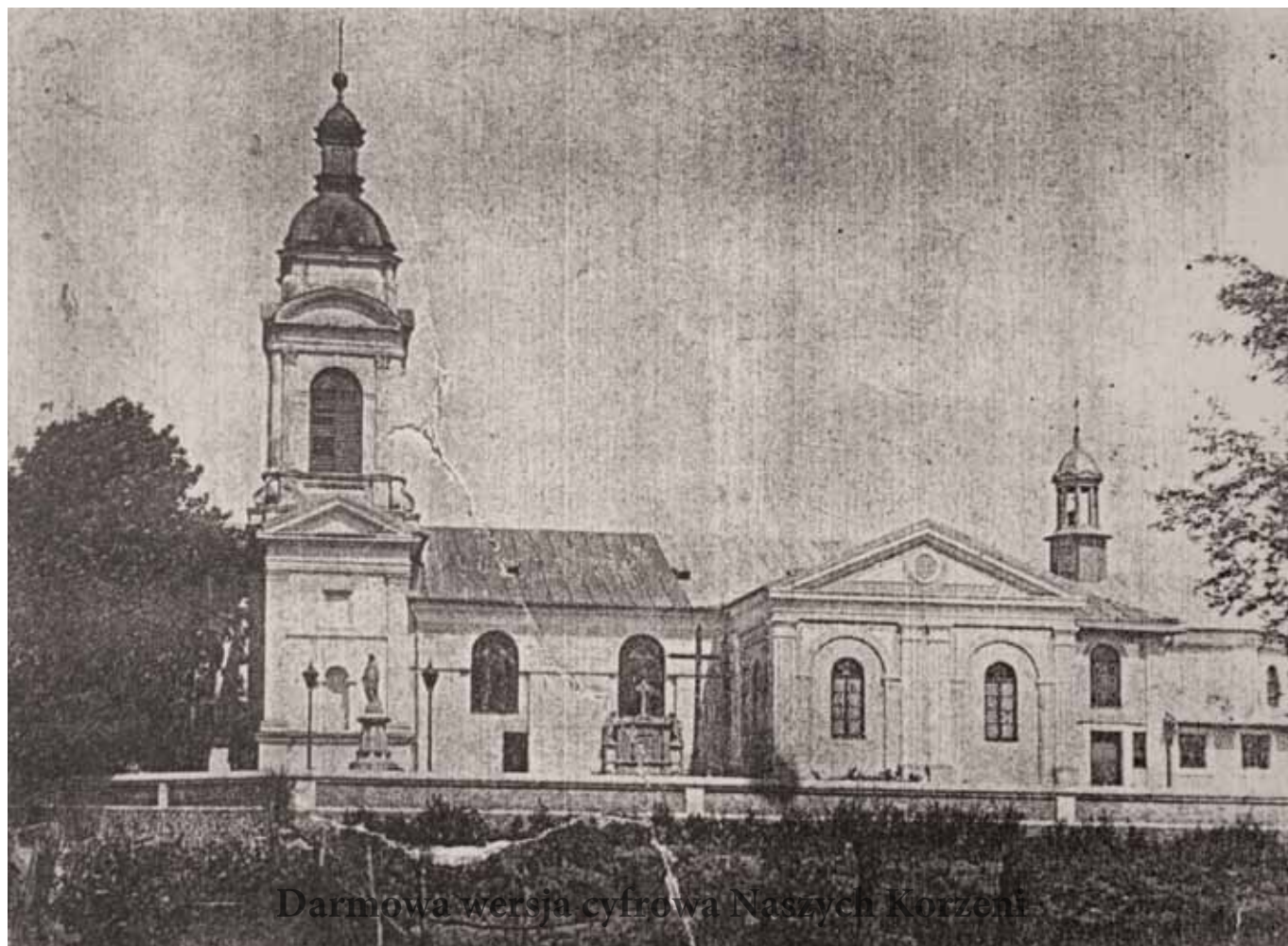
Kościół w Orszymowie po rozbudowie w 1910 r.
